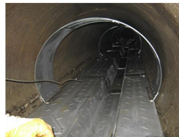
Integrierter Wärmetauscher (UHRIG)
