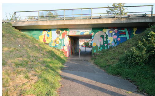
Abbildung 022: Fuß- und Radunterführung der Bundesstraße 19
